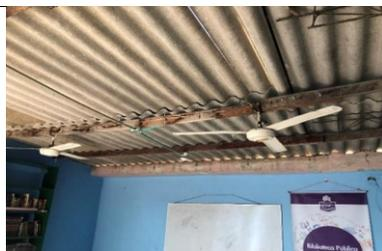
Imagen 2 – Cubierta en mal estado y deteriorada
