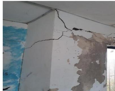
Imagen 2 – Muros agrietados
