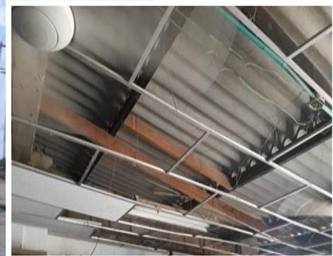
Imagen 3 – Cubierta con filtraciones
