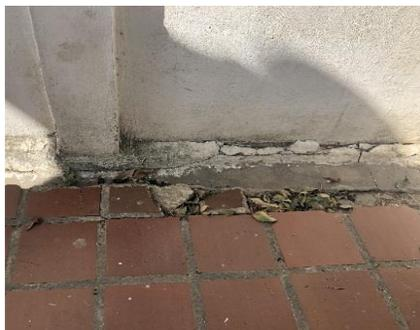
Imagen 4 – Andenes fatigados y deteriorados por raíces.
