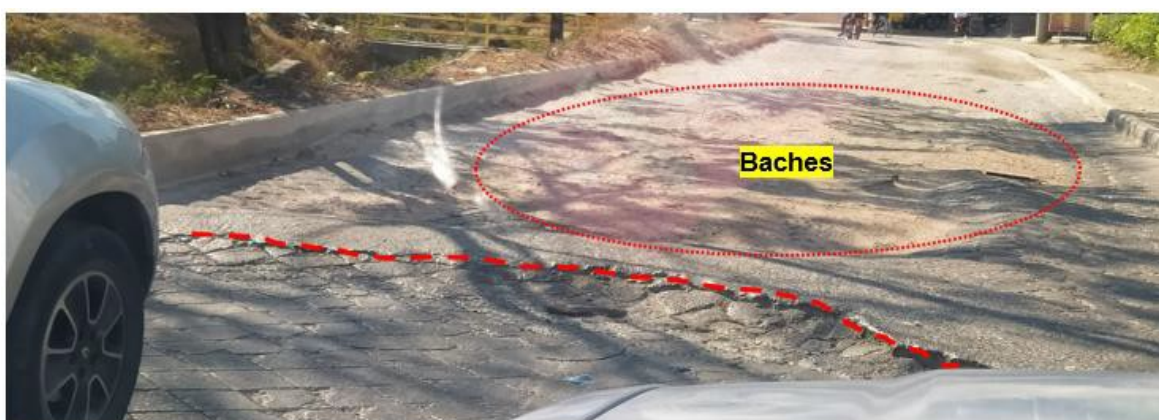
Figura 6. Hundimientos y levantamientos por deformación de la superficie en la calzada derechaFuente: Tomado de oficio AMC-OFI-0027579-2023
