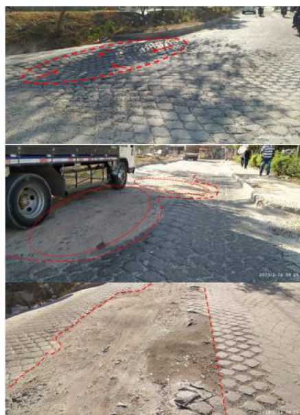
Figura 4. Hundimiento (arriba), Baches por desintegración y remoción de parte de la superficie del pavimento en Sistema de Geoweb (calzada derecha). Fuente: Tomado de oficio AMC-OFI-0027579-2023
