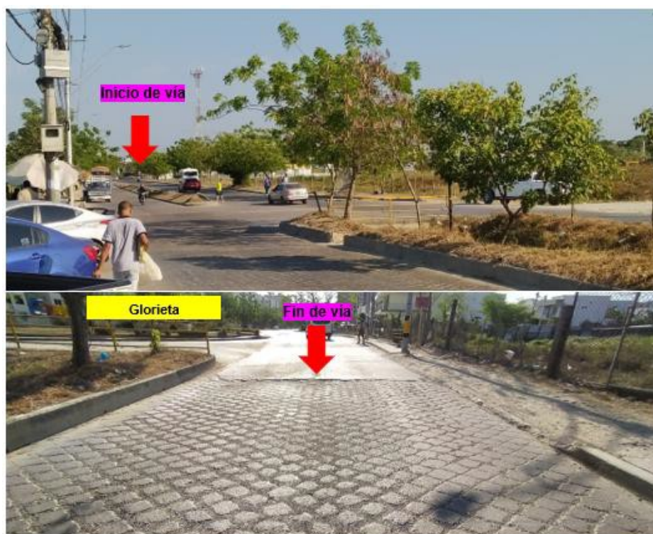
Figura 3. Vista parcial de inicio y fin del tramo de Vía La Carolina. Fuente: Tomado de oficio AMC-OFI-0027579-2023
